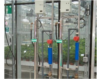
UV Anlagen zur Desinfektion von Prozesswasser im Gartenbau VAP SD 60 I für 200l/h Deutschland
