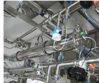
UV-Anlage in Pharmaausführung zur Restozonvernichtung EL-PH 089 für 12m 3 /h Deutschland
