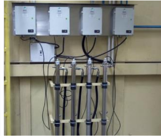
UV-Anlagen zur Chemikaliendesinfektion 4x VAP SD 75 für 1m 3 /h Brasilien
