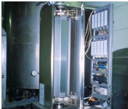
Positive Bestrahlungsgeometrie zur Desinfektion 40 m 3 /h Deutschland
