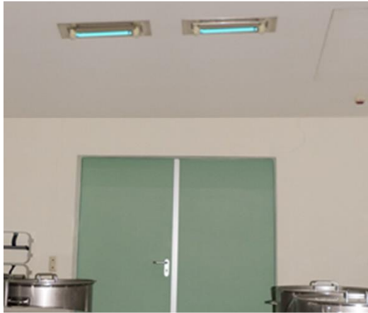
UV-Systeme zur Luftdesinfektion in Lagerräumen der Kosmetikindustrie Deutschland
