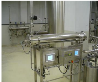
UV-Anlage in Pharmaausführung zur Restozonvernichtung EL-PH 165 für 23m 3 /h Türkei
